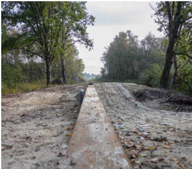
Afb. 21. Aanleg stuw voor veenvernatting.
