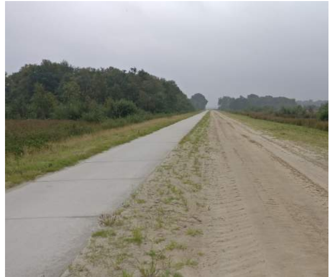
Afb. 20. Verbreed fietspad in natuurgebied Bargerveen waar brandweerauto's overheen kunnen met gemaaide bermen waardoor een brede brandgang ontstaat.
